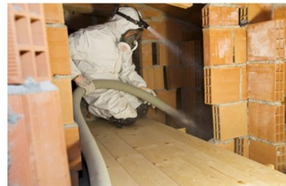
Insufflaggio del sottotetto con fiocchi di cellulosa Climacell
